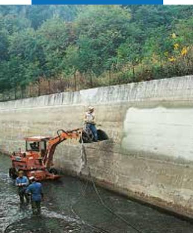
Нанесение Planiseal 88 пульверизатором в гидроэлектрическом канале
