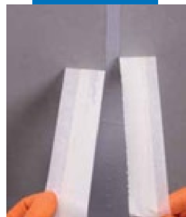
Удаление защитной ленты с кромок шва
