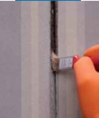
Нанесение грунтовки Primer M
