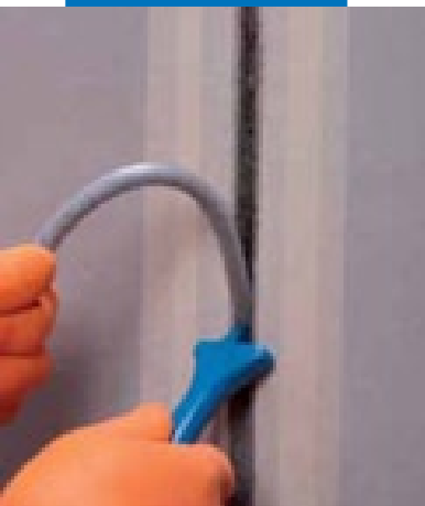
Укладка шнура Mapreflex в шов
