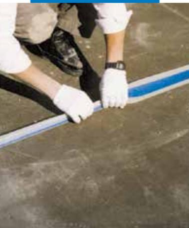
Пример гидроизоляции компенсационных швов на террасе
