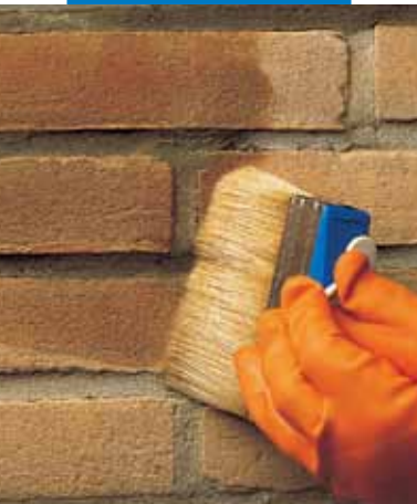
Нанесение Antipluviol S кистью
