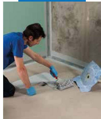
Установка Drain Vertical , используя Mapegum WPS
