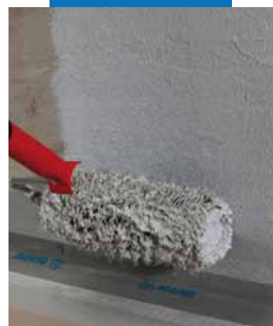
Нанесение Mapegum WPS с помощью валика
