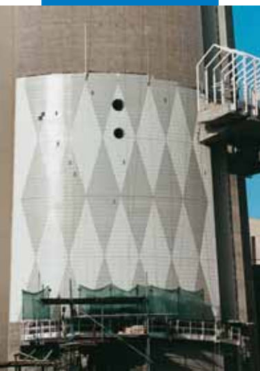
Пример укладки клинкера поверх бетона с помощью Kerabond T + Isolastic. Новая телекоммуникационная башня в Кувейт - сити (Кувейт)
